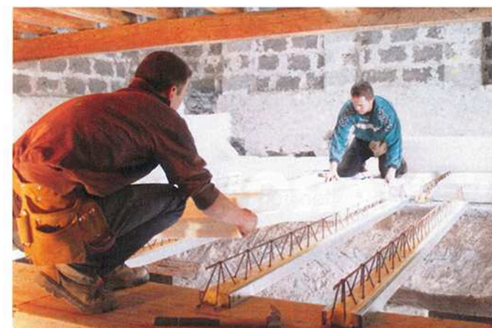
2 La pose des entrevous en polystyrène moulé détermine la position définitive des poutrelles. La première est fixée pour permettre de mieux répartir les autres.
