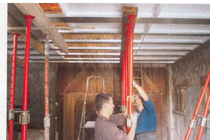
3 L'étalement est réalisé très attentivement avec des madriers correctement dimensionnés. Les maçons respectent le positionnement des lignes d'étais du plan de pose.
