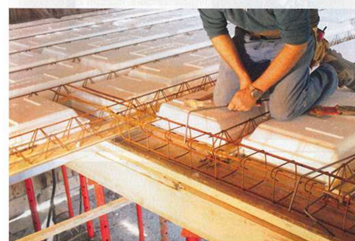
5 La mise en place du ferrailage complémentaire garantit la bonne tenue mécanique du plancher. Ici, le maçon pose un chapeau de liaison sur le chevêtre de la trémie d'escalier.
