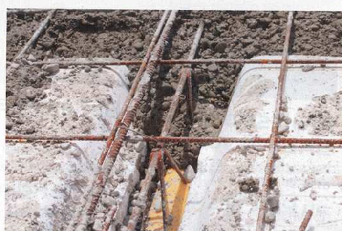
8 Le coulage du béton à 350 kg commence en périphérie du coffrage. Il se poursuit dans les nervures et s'achève par la table de compression en évitant du surpoids sur les hourdis.
