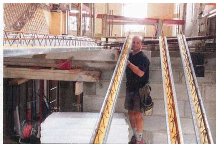
1 Les poutrelles PSI en tôle galvanisée remplies de mousse polyuréthane en 5 m de long ne pèsent que 20 kg. Le maçon peut ainsi se passer d'engins de manutention sur le chantier.
