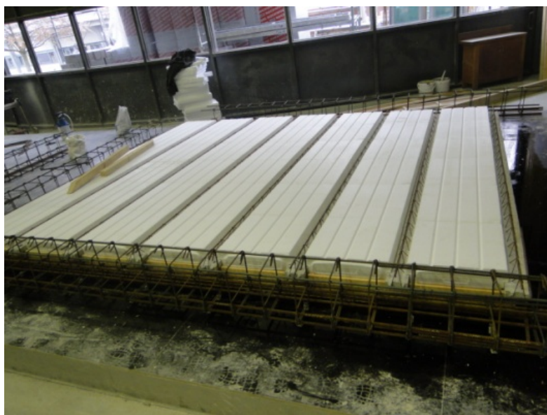
Photographie 4 - Mise en œuvre des entrevous moulés en PSE entre poutrelles
