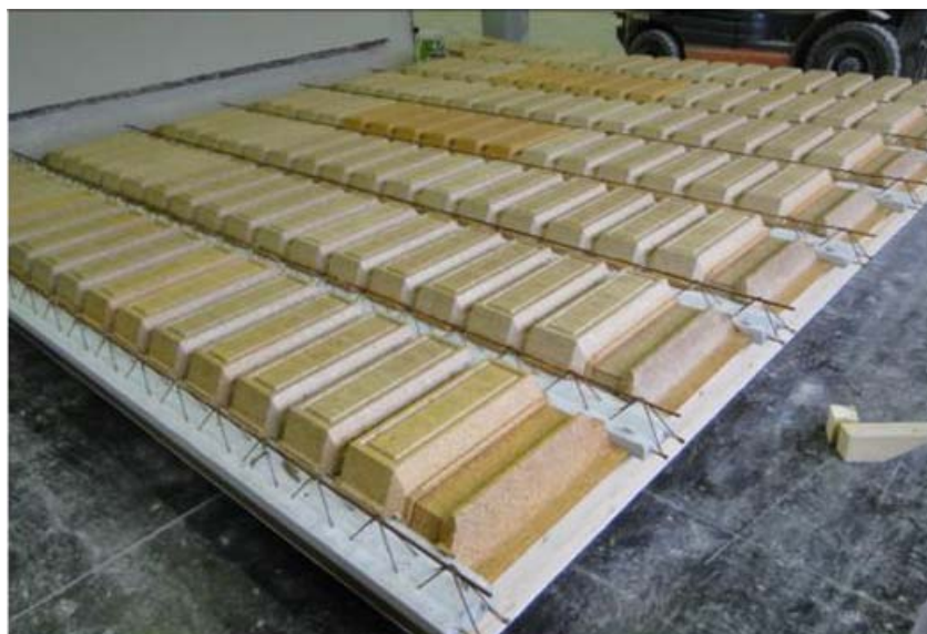
Photographie 2 - Mise en œuvre des entrevous en bois moulés entre poutrelles
